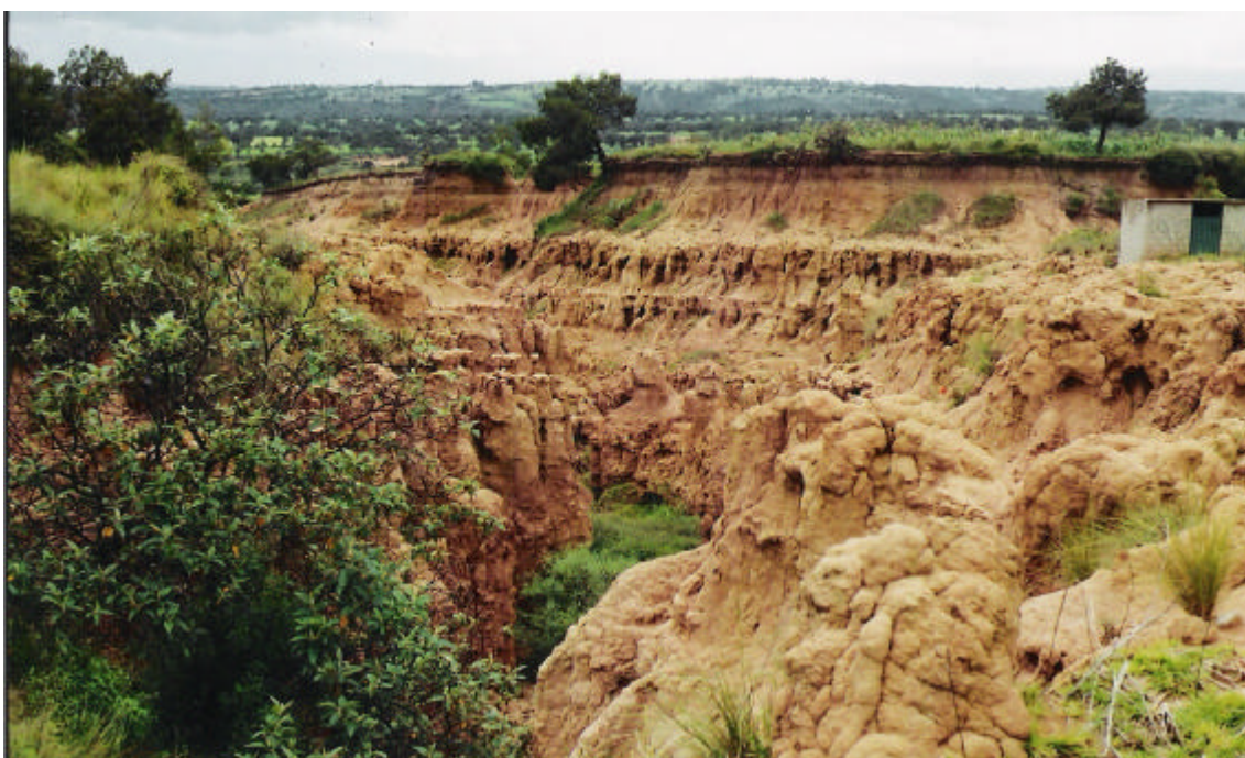
Fotografía 2 Erosión muy alta
