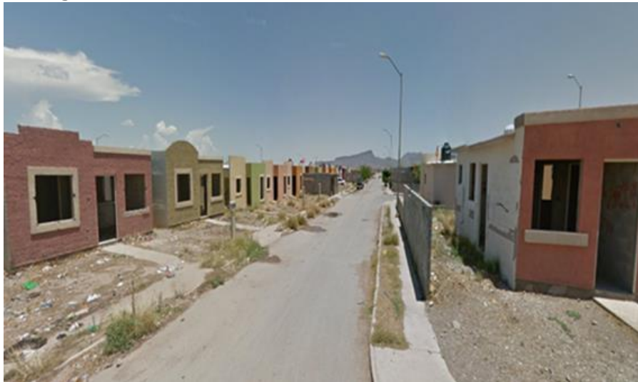
Imagen 8. Viviendas abandonadas en la colonia Punta Oriente.
