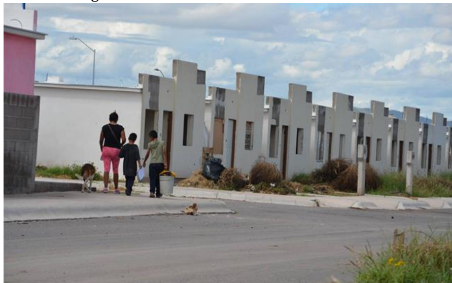
Imagen 9. Viviendas en la colonia Punta Oriente.
