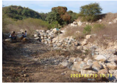
Figura 11. Zona 2. Cauce: Campo de Tiro. Extracción de rocas.
