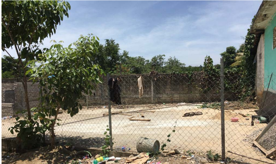
Figura 6. Deshidratador de piso firme y malla ciclónica.
