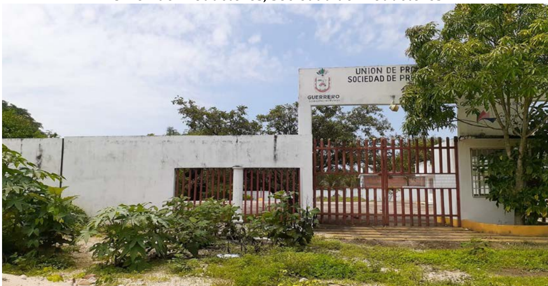
Figura 7. Instalaciones abandonadas de la procesadora de jamaica en Tecoaapa, Unión de Productores, Sociedad de Productores
